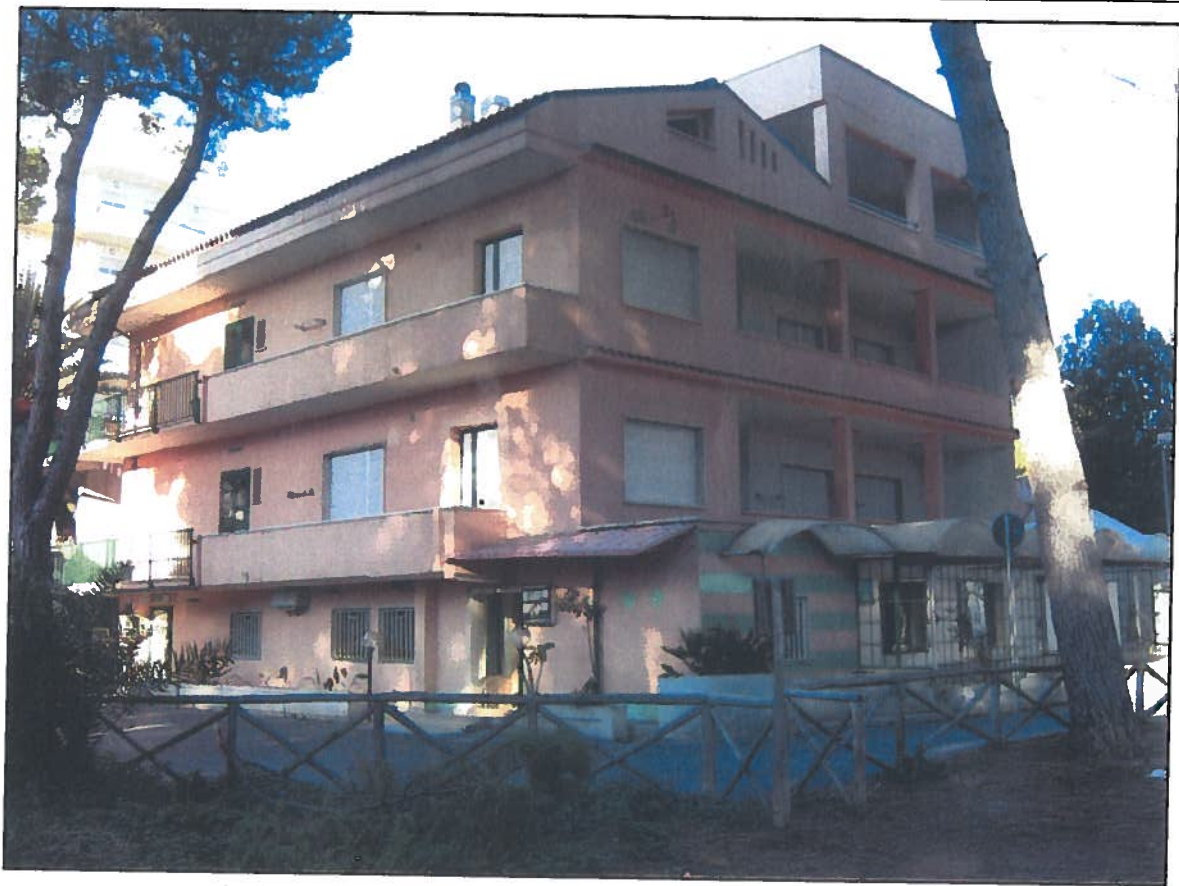
Foto n. 1: veduta esterna dell'edificio dalla Pineta.
