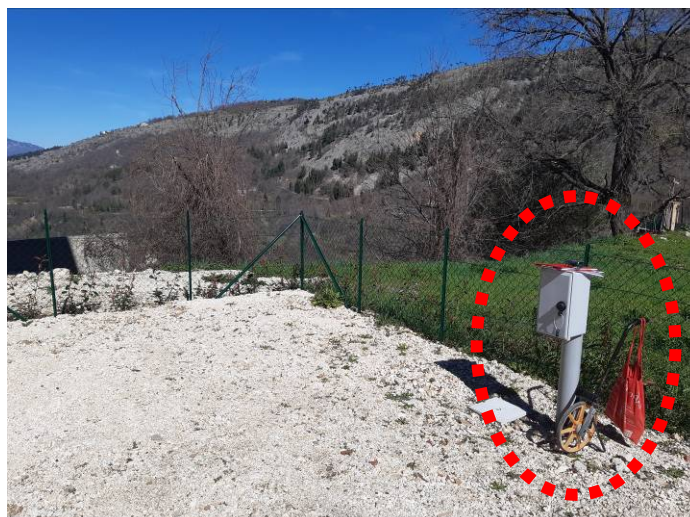
Immagine #12 – Postazione di Caramanico – Foto colonnina adduzione elettrica
