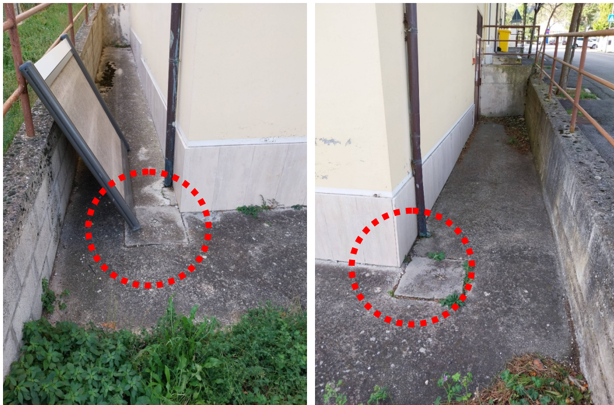
Immagine #18 – Postazione di Civitella Casanova – Pozzetti rete acque bianche
