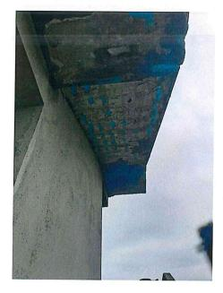
Da una delle solette rampanti della gradinata Est lato Ospedale si è verificato il distacco di una porzione di intonaco che è rovinata a terra e causando una situazione di pericolo per l'incolumità pubblica in quanto, in detta gradinata, transitano numerosi dipendenti dell'Azienda che dopo aver parcheggiato nel silos multipiano, scendono da detta scala per recarsi sul posto di lavoro.
